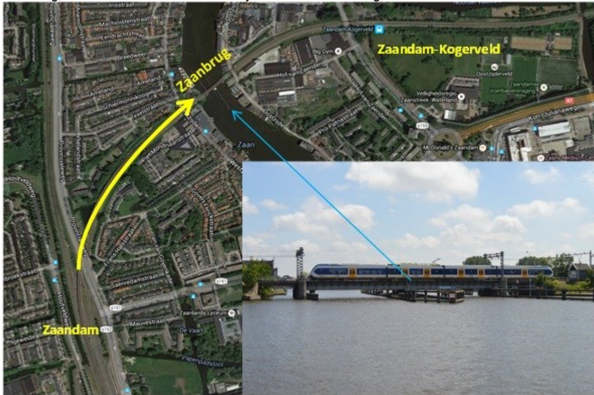
Figuur 1. Ligging en aanzicht van de Zaanbrug tussen Zaandam en Zaandam Kogerveld.
