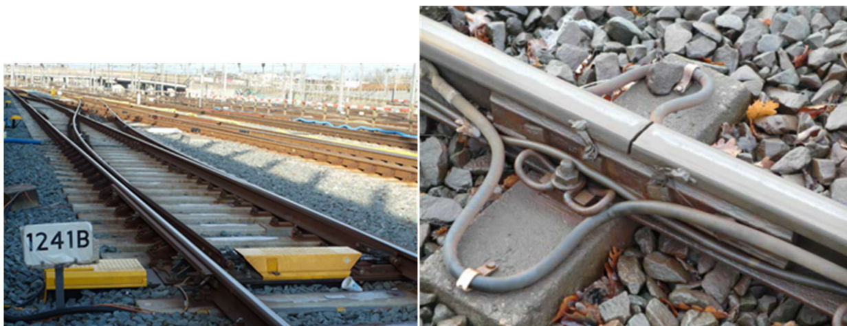
Figuur 3.4: voorbeelden van een wissel (links) en een ES-las (rechts)
