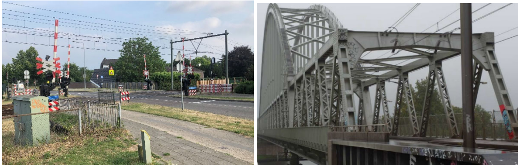
Figuur 3.5: voorbeelden van een overweg (links) en een overgang aarden baan naar kunstwerk (rechts)
