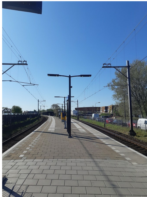
Station Castricum: LED-verlichting met aanwezigheidsdetectie
