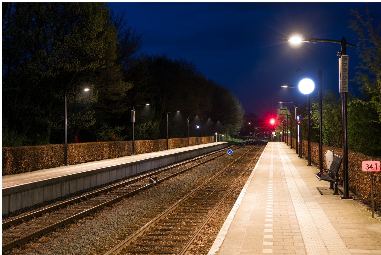
Foto: LED-verlichting met aanwezigheidsdetectie station Groenlo - Lichtenvoorde.
