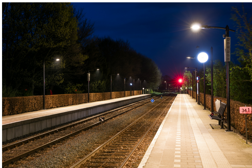
Foto: LED-verlichting met aanwezigheidsdetectie station Groenlo - Lichtenvoorde.
