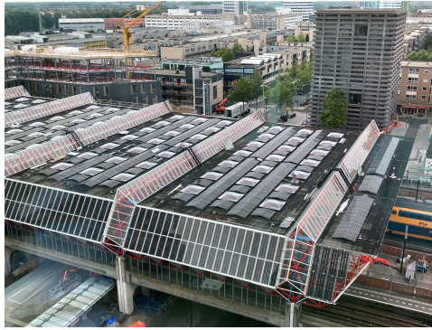
Foto: zonnepanelen station Almere Centrum
