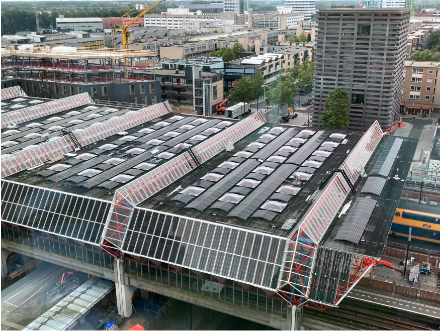
5.1: foto zonnepanelen station Almere Centrum.
